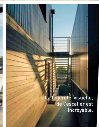
Le fait d'installer deux types de bardage, en bois et en acier, permet de souligner l'architecture cubique de la maison et les différents espaces de vie.
